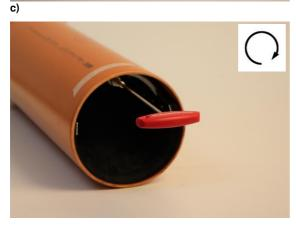
c) Schraube in Pfeilrichtung mit originalwerkzeug fixieren. Die Schraube muss im Scheitelbereich Fixiert werden.
