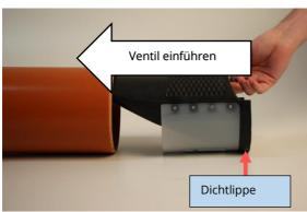
**b)** Das Ventil in das Rohr schieben bis die Dichtlippe ganz im Rohr aufliegt. Siehe Abb. c
