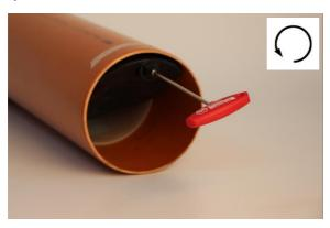
c) Schraube in Pfeilrichtung (Gegenuhrzeigersinn) fixieren. Um ein optimales Funktionieren zu garantieren, muss die Schraube im Scheitelbereich der Röhre fixiert werden.
